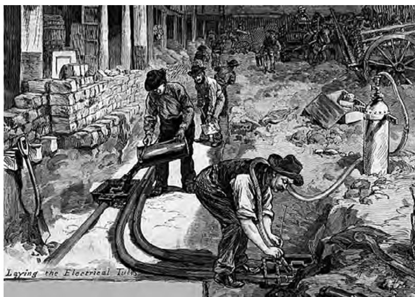
RYSUNEK 9.3. Fragment ilustracji z 21 czerwca 1881 roku z „Harper’s Weekly” zatytułowanej „Światło elektryczne w domach — wykładanie kabli pod przewody na ulicach Nowego Jorku”. Edison uznał, że lepiej będzie zakopać kable pod ziemią niż wieszać je na słupach
